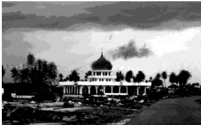
Gambar 1.8 Keadaan Lingkungan Akibat Gelombang Tsunami di Aceh
